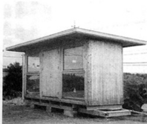
▲ボアズパネル工法で建てた試験棟。 スギ角材を縦に連結して壁を構成している
