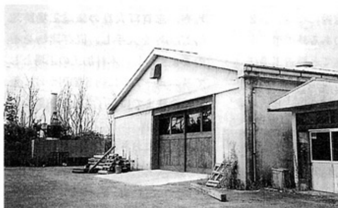
敷地2500坪を有するボアズ事業の木材加工の既存工場一部
