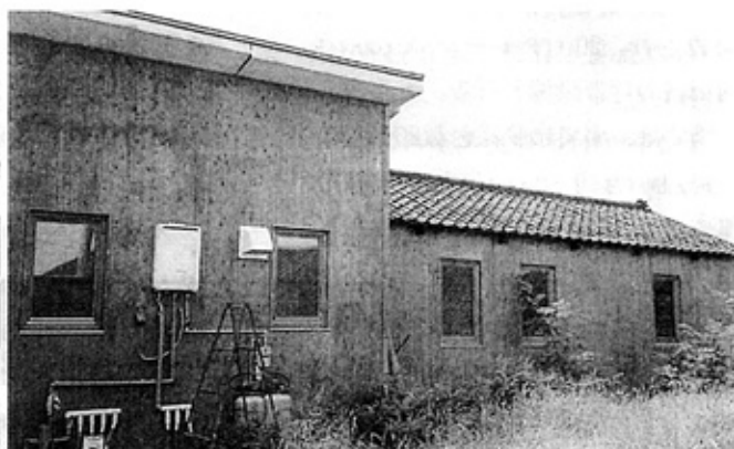
改装工事を終えたばかりの宿泊施設も併設
