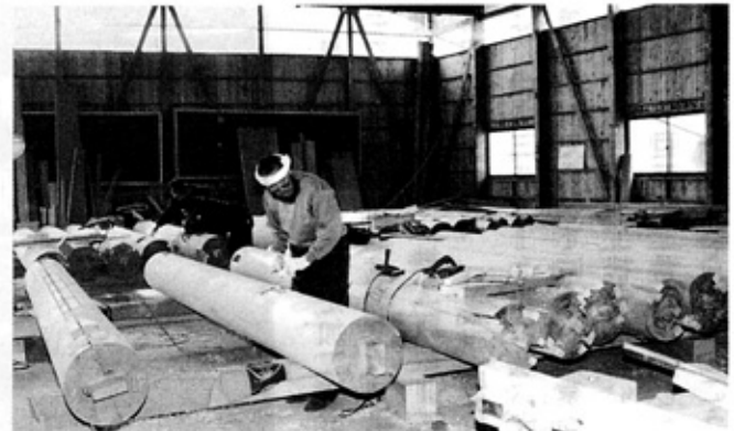
▲社寺工舎作業所で宮大工の手による仕上げ加工が
