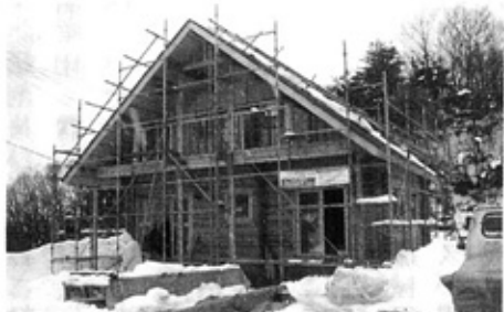
▲角ログで建築中の千石工場事務所棟。 角ログのモデルハウス兼用
