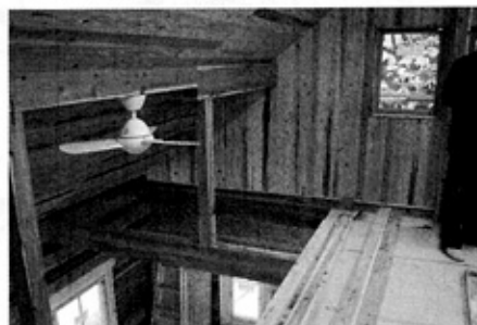
▲1階ふき抜きをを2階から見る
